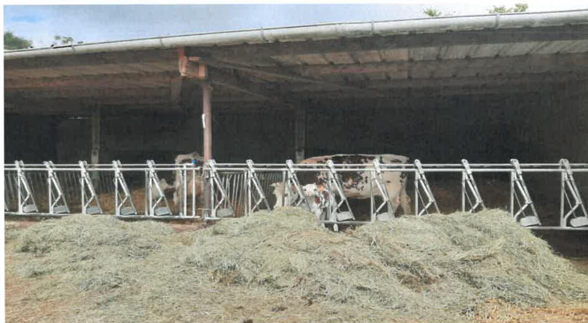
Bâtiment 3 : logement aire paillée vaches tarées / veaux
